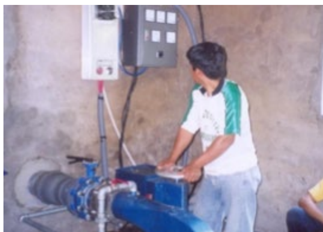
Figura 8. Apertura del álabe directriz. Fuente: Archivo fotográfico de Soluciones Prácticas
